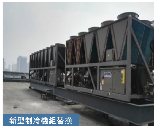
新型制冷機組替換
