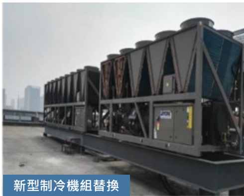
新型制冷機組替換
