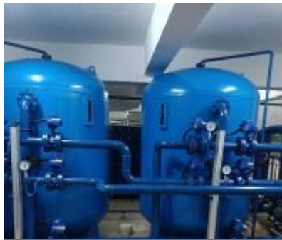
越南生產中心雨水回收處理系統
